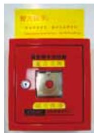
每侧站台侧墙上各设有2个紧急关闭按钮，拔开活络有机面板，按压即可。
